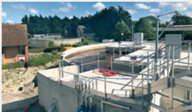
Station d'épuration de la ville du Crotoy
