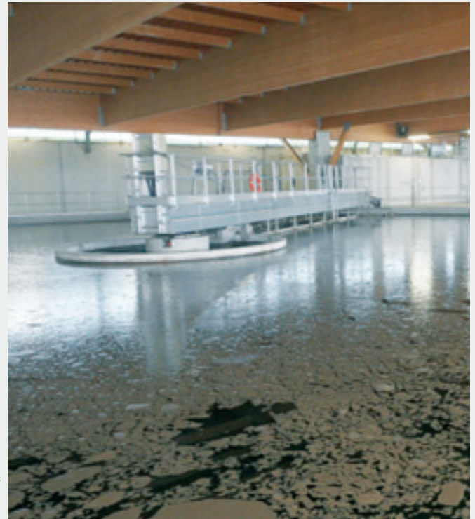
La station d'Ambonne (inaugurée en 2017) est en partie souterraine, ici, le traitement biologique
