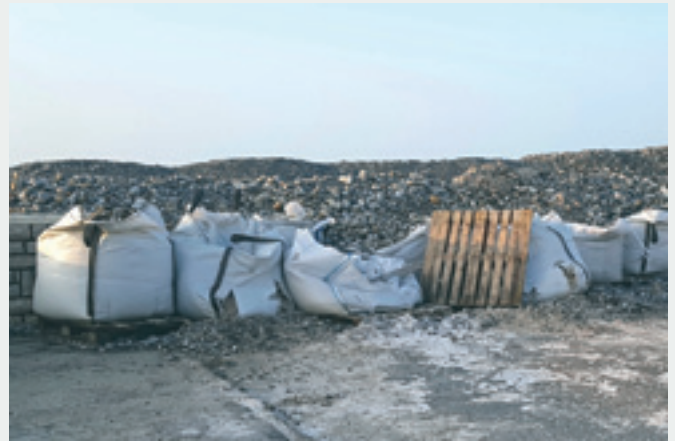
Big-bags de galets pour empêcher la mer d'inonder le centre de Cayeux-sur-mer. Des blocs de bétons renforcent la protection
