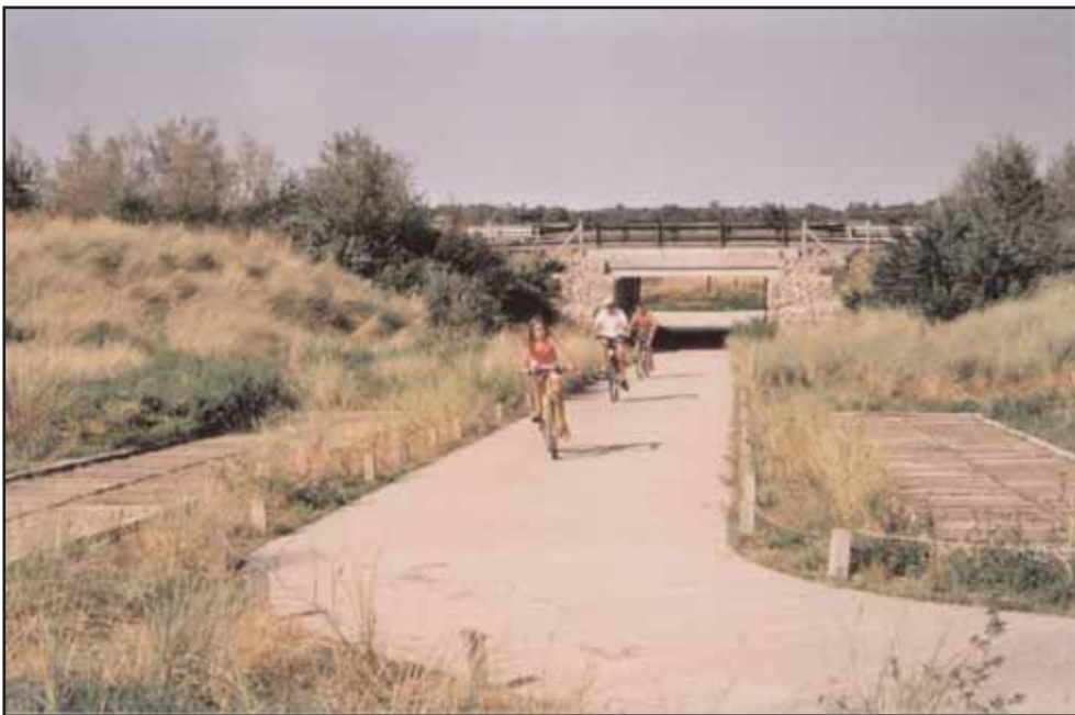
Près de l'ancienne station de traitement des coquillages au Crotoy, la piste cyclable passe sous la digue. (J.-M. Hæblich, 2001)
