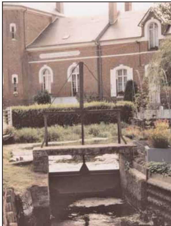
Une écluse, héritage du contrôle de l'eau dans les courses à Favières (J.-M. Hoeblich – 2004)
