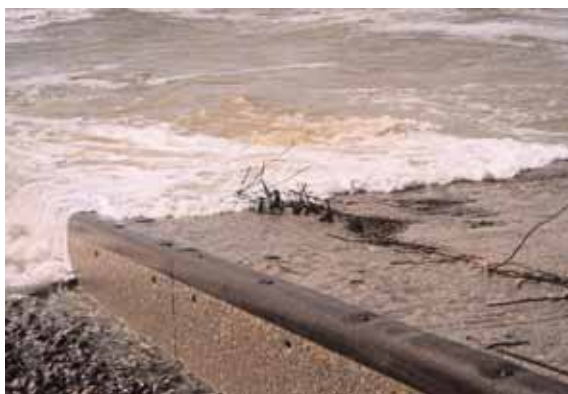
Document 5 : L'assaut des houles projetant les galets rend vulnérables les épis. Ici, le dernier épi, près de l'amer sud de Cayeux, peu de temps après sa mise en place. (Photo : V. Bawedin, 2003).
